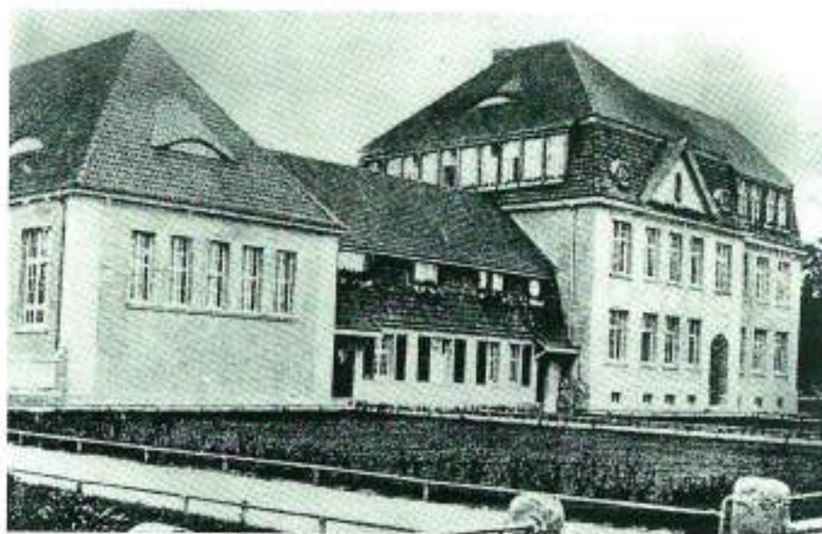
Gebäude im Jahr 1914
